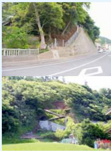
写真上：港町地区緊急避難道路 写真下：浜那久地区緊急避難道路
